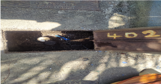
Contador de Agua
