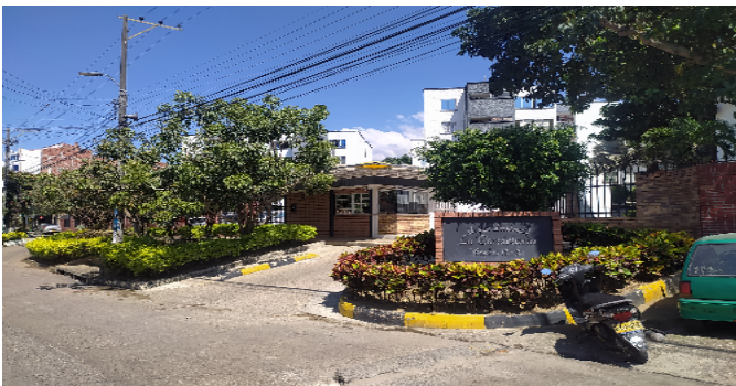
Fachada del Inmueble
