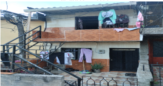
Fachada del Inmueble
