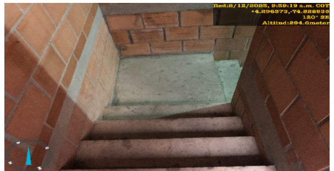
Escalera común - CJ
