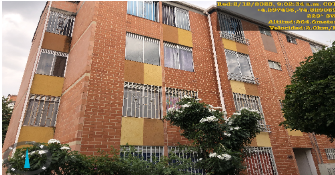
Fachada del Inmueble
