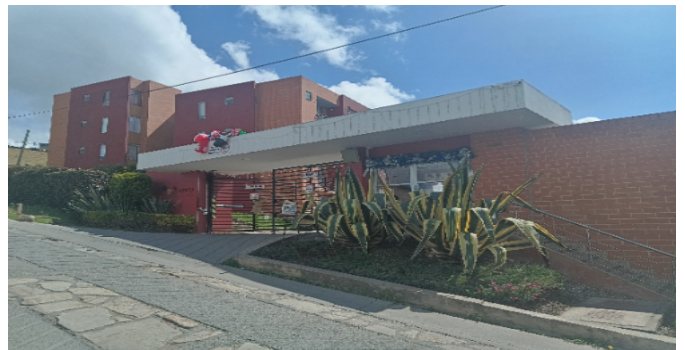
Fachada del Inmueble
