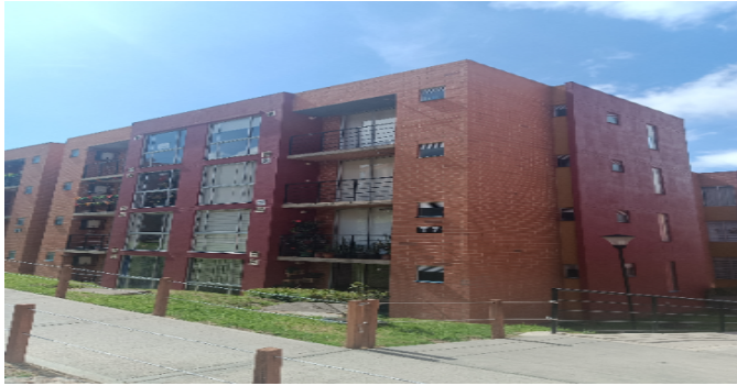
Fachada del Inmueble
