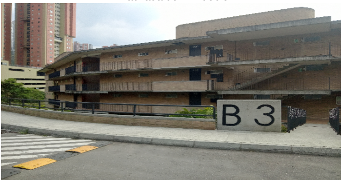
Fachada del Inmueble
