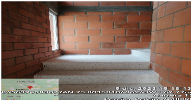
Escalera del inmueble
