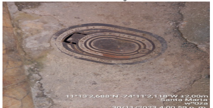
Contador de Agua
