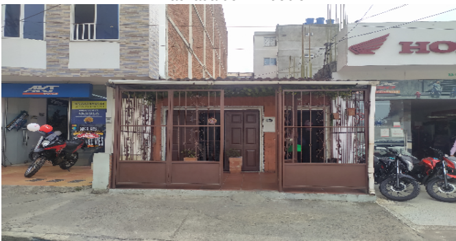
Fachada del Inmueble
