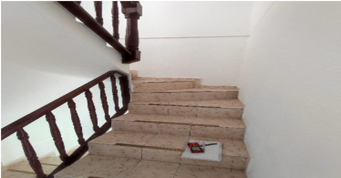
Escalera del inmueble
