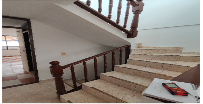
Escalera del inmueble
