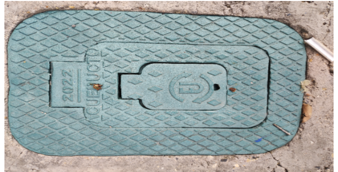
Contador de Agua
