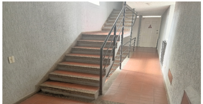
Escalera común - CJ
