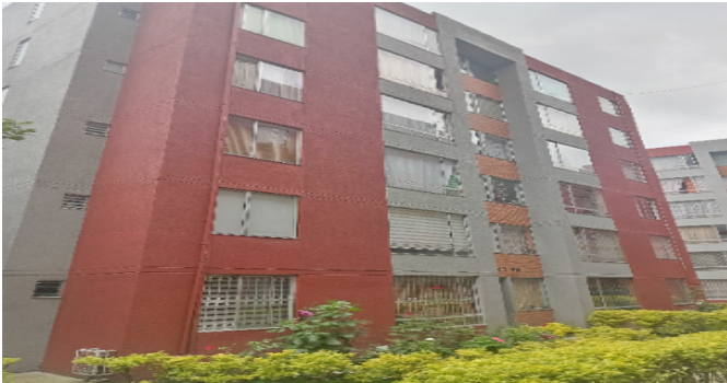
Fachada del Inmueble
