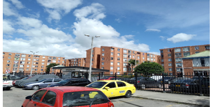
Fachada del Conjunto
