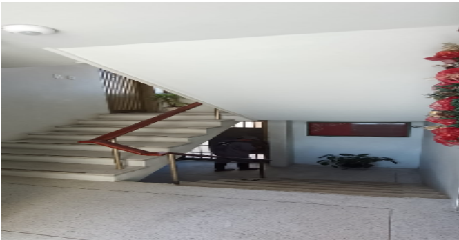
Escalera común - CJ
