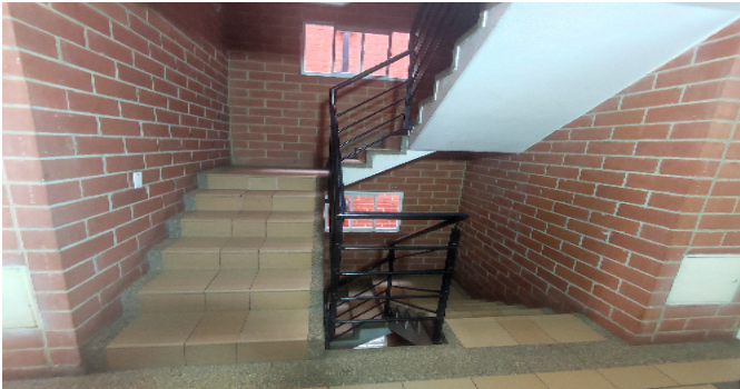
Escalera común - CJ
