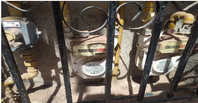
Contador de Agua
