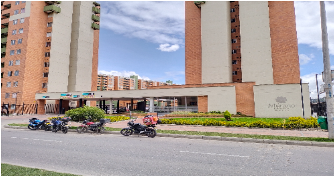
Fachada del Inmueble
