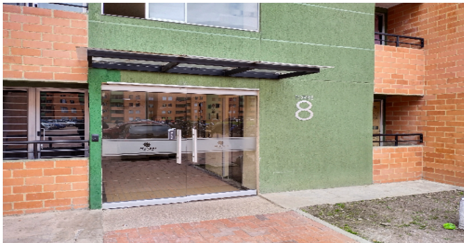
entrada a la torre
