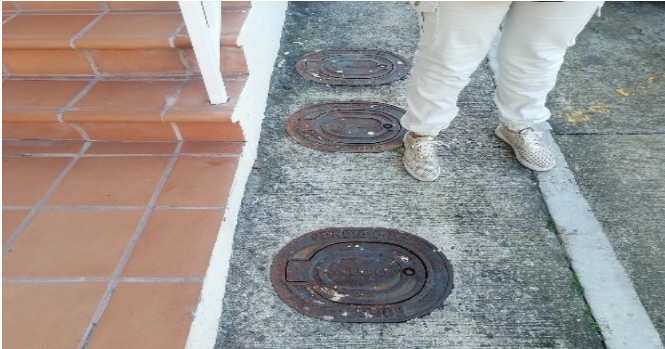
Contador de Agua
