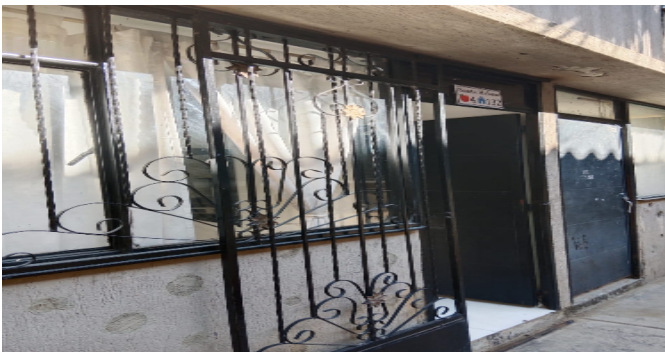
Fachada del Inmueble
