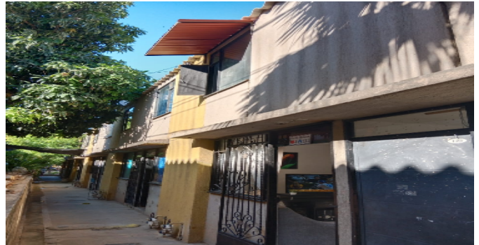
Fachada del Inmueble
