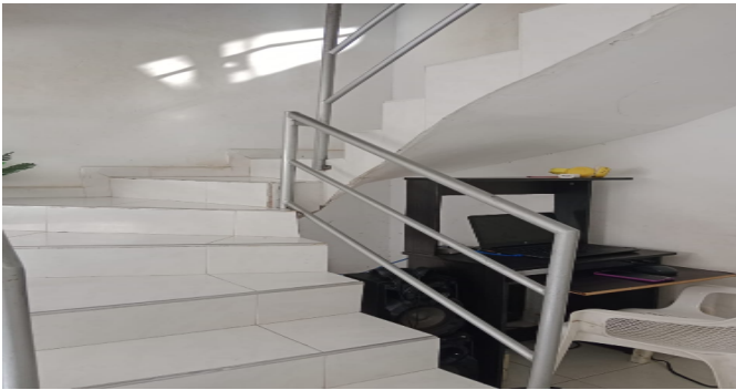
Escalera del inmueble
