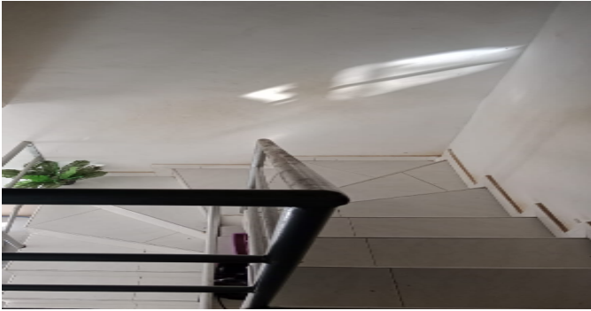
Escalera del inmueble
