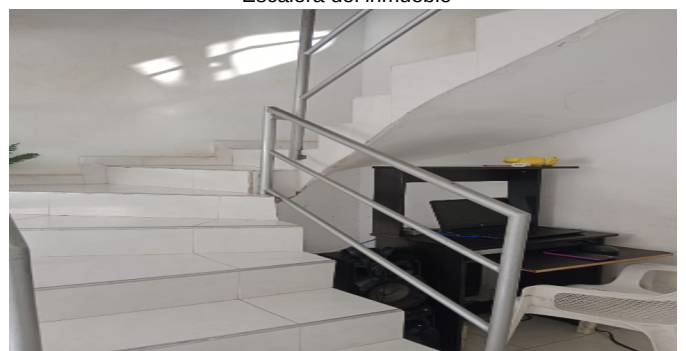
Escalera del inmueble
