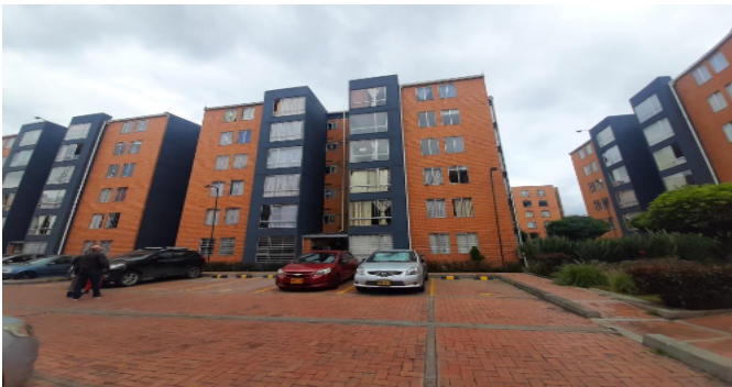
Fachada del Inmueble
