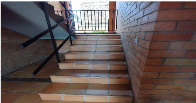
Escalera común - CJ
