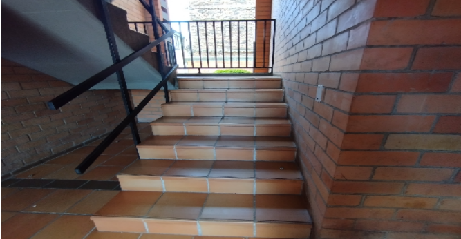
Escalera común - CJ
