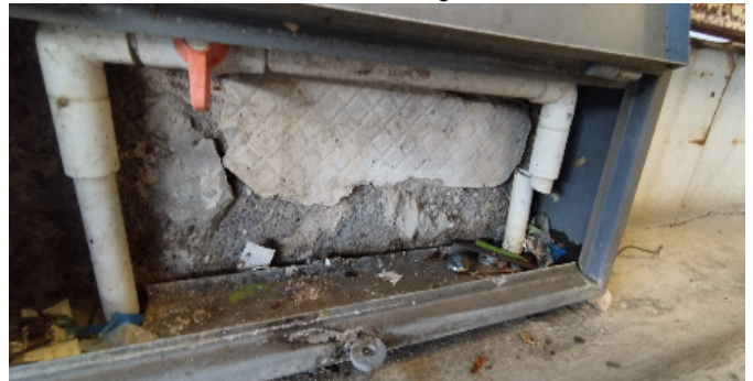
Contador de Agua
