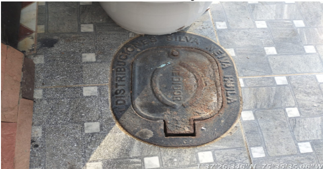
Contador de Agua
