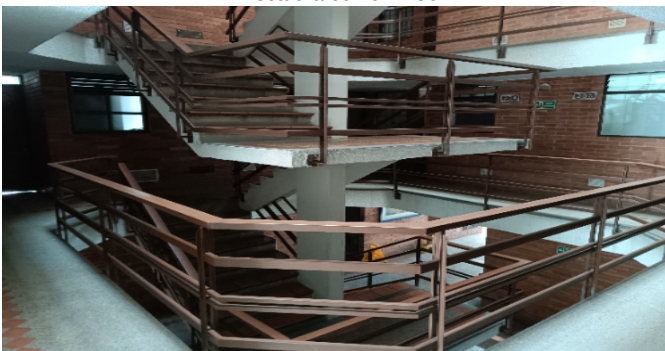
Escalera común - CJ
