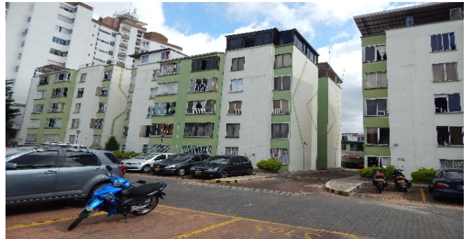
Fachada del Inmueble
