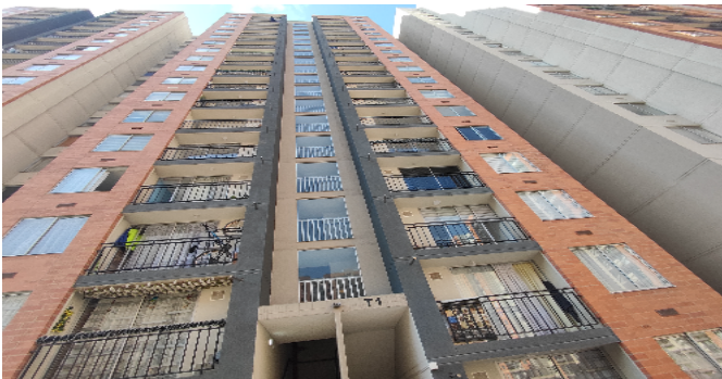
Fachada del Inmueble
