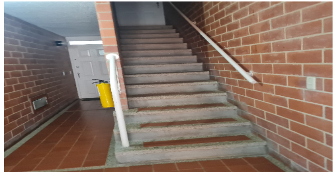
Escalera común - CJ
