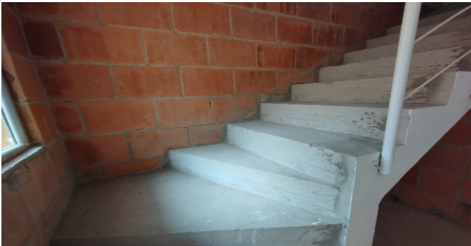
Escalera del inmueble
