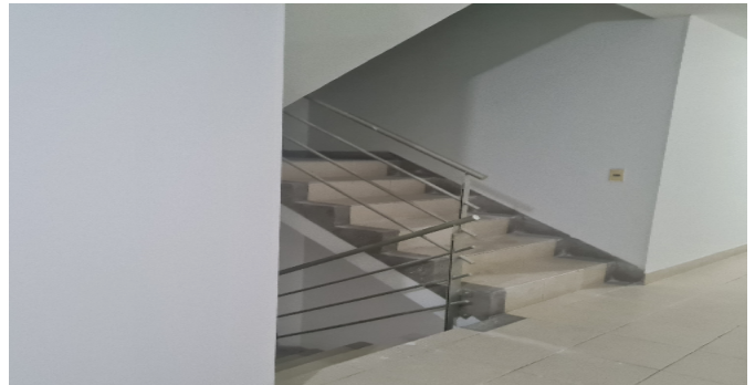
Escalera común - CJ
