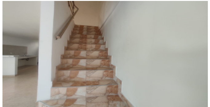
Escalera del inmueble
