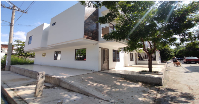
Fachada del Inmueble
