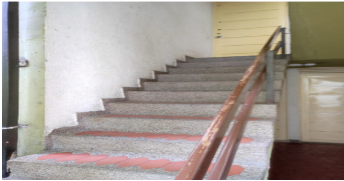
Escalera común - CJ
