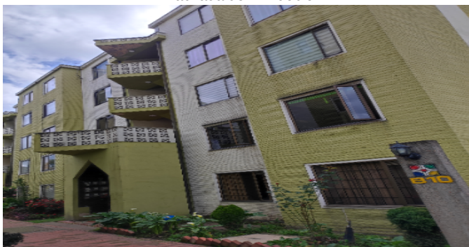
Fachada del Inmueble
