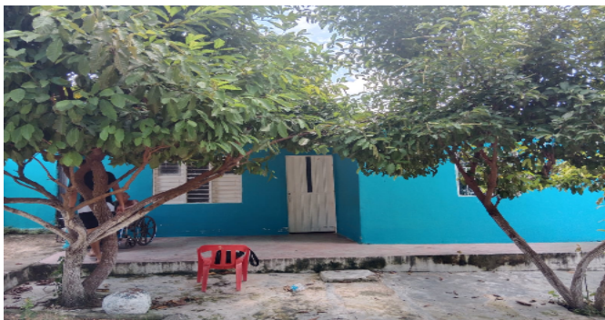
Fachada del Inmueble
