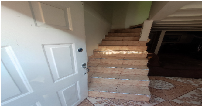
Escalera del inmueble
