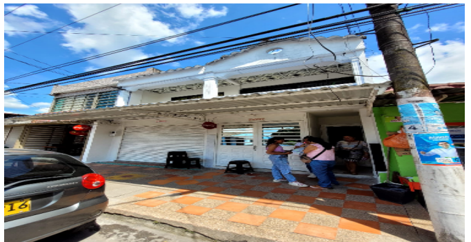
Fachada del Inmueble
