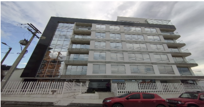
Fachada del Inmueble
