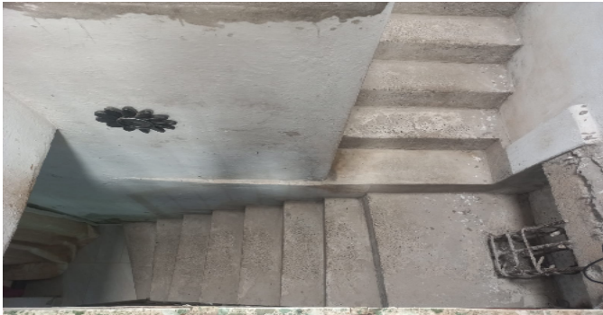
Escalera del inmueble
