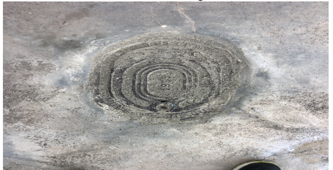
Contador de Agua
