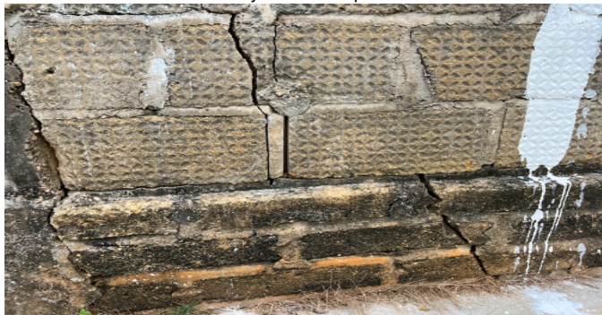
Grietas y fisuras de pñ redes
