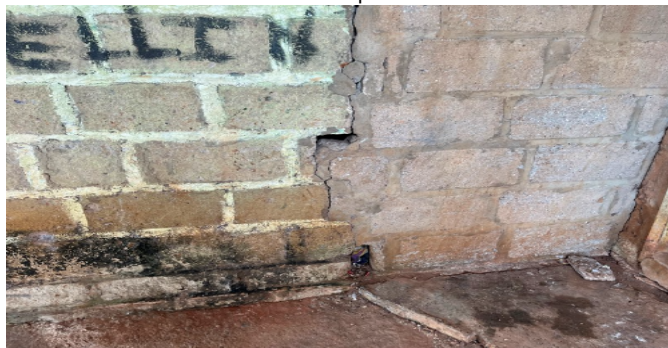
Fisuras en paredes
