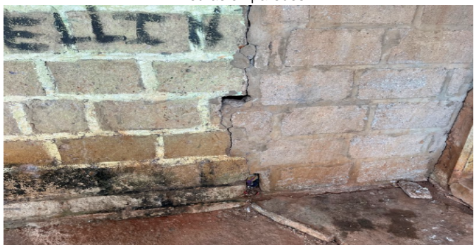
Fisuras en paredes
