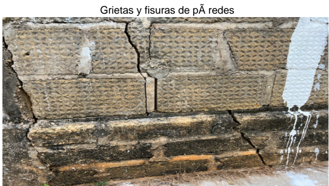
Fisuras en paredes
