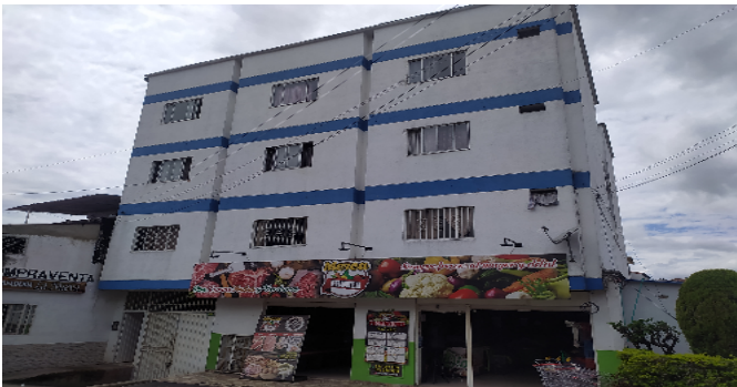
Fachada del Inmueble
