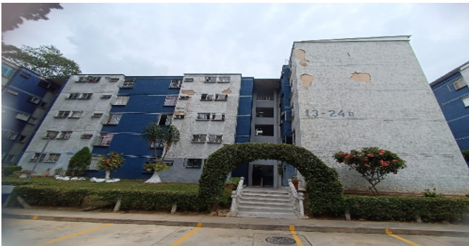
Fachada del Inmueble
