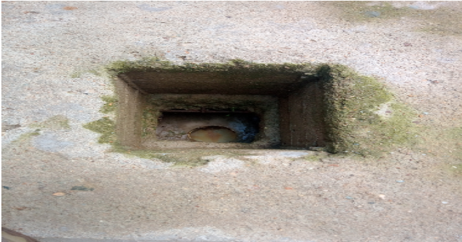
Contador de Agua
