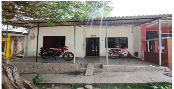
Fachada del Inmueble
