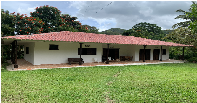
Fachada del Inmueble
