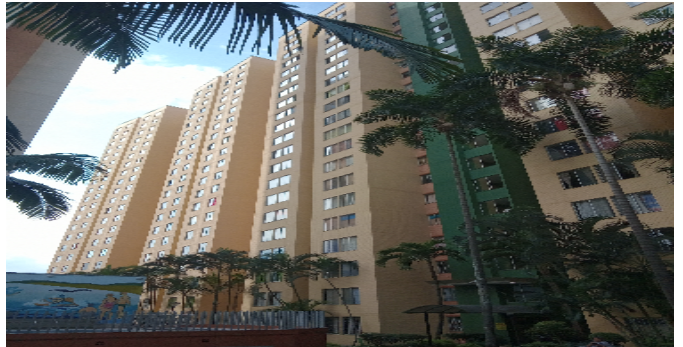
Fachada del Inmueble
