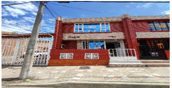
Fachada del Inmueble
