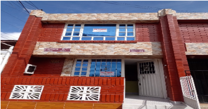
Fachada del Inmueble
