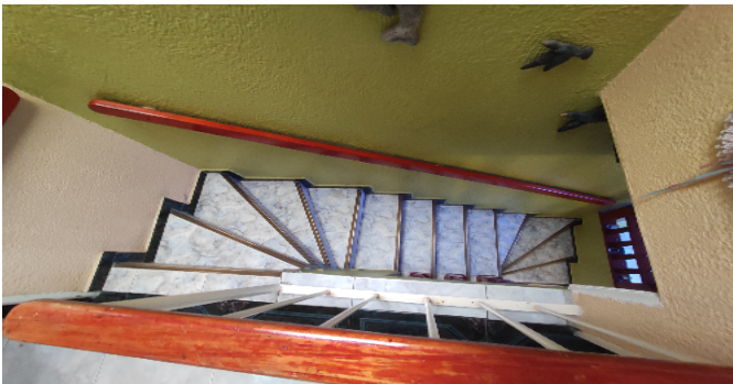
Escalera del inmueble
