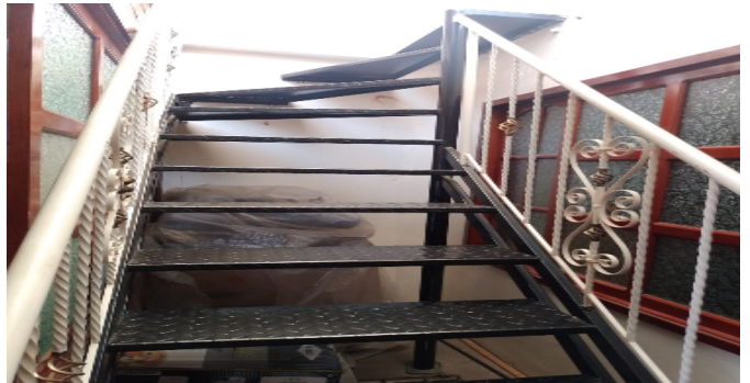
Escalera del inmueble
