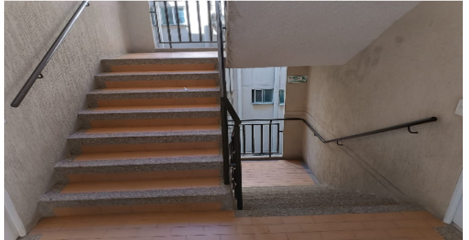
Escalera del inmueble
