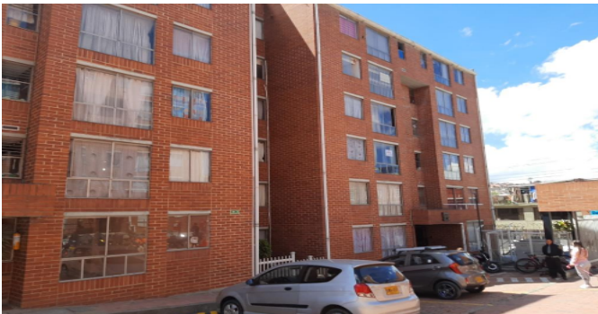
Fachada del Inmueble
