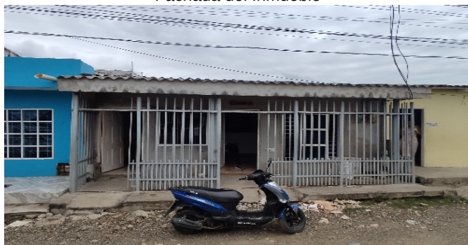
Fachada del Inmueble
