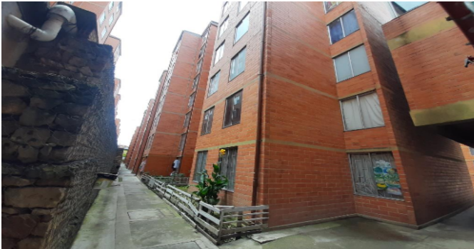
Fachada del Inmueble
